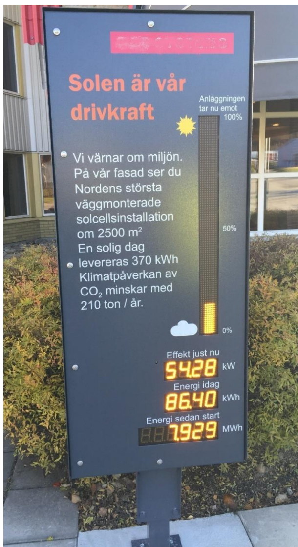
Figur 4. Ett exempel på display från Borg för placering utomhus som presenterar effekt genom en stapel och elproduktion per dag och totalt i siffror.
